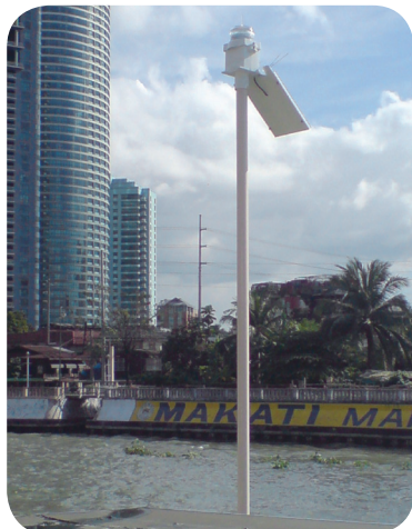
Proyecto de rehabilitación del paseo del río Manila, Filipinas
